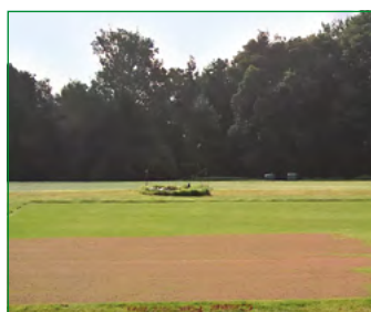
Vorbereitung der Fläche
